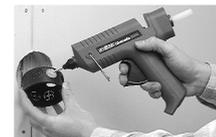
Установка соединительных коробок в стенах легких конструкций.
